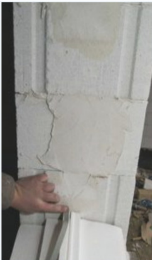
Zdj. nr. 2. Powierzchnia otworu okiennego wyrównana zaprawą, Ciepły parapet
